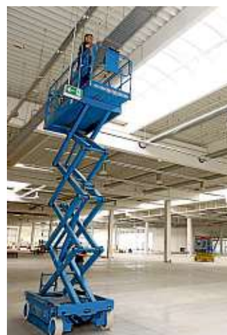
Im Inneren sind die Handwerker derzeit unter anderem mit Elektroarbeiten beschäftigt.
