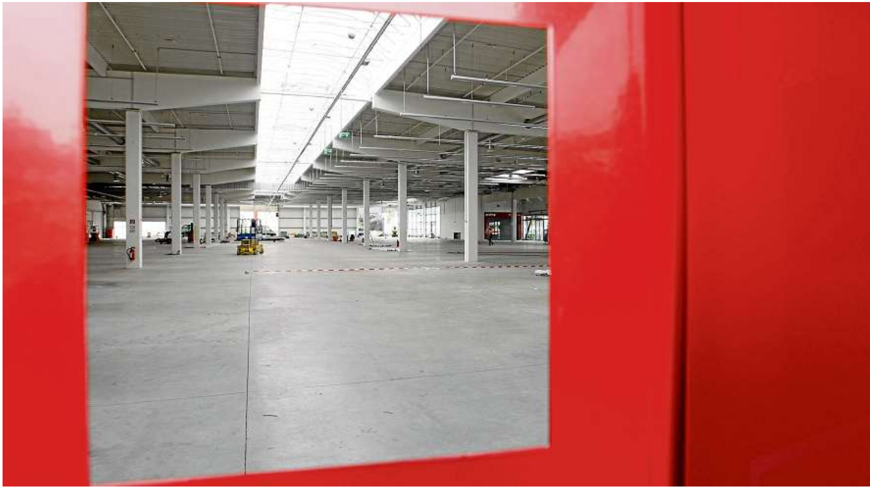
Ein Blick in das ehemalige Max-Bahr-Gebäude am Zollpost zeigt: Es geht voran. Im Herbst soll an dieser Stelle ein neuer Hornbach-Markt eröffnet werden. Foto: Milk
