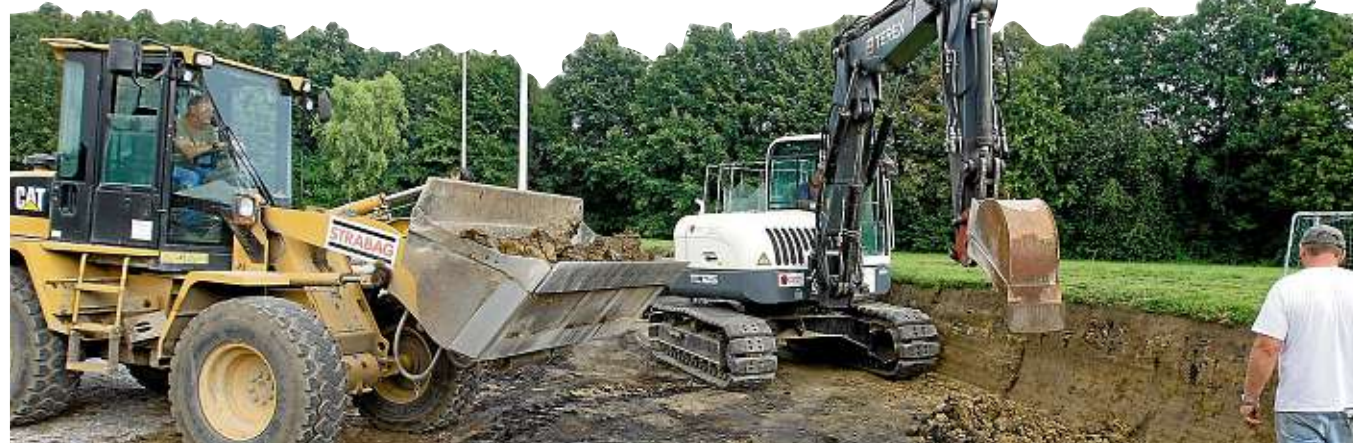
Auch im Jahnstadion geht es voran. Die Arbeiten laufen parallel. Beide Anlagen sollen fristgerecht im Herbst fertiggestellt sein. Foto: Milk
