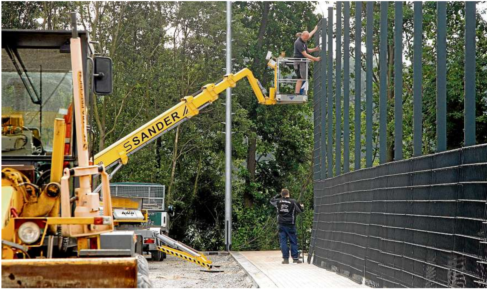
Die Sportplätze an der Gesamtschule und im Jahnstadion werden zu Kunstrasenplätzen umgebaut. Es entsteht Deutschlands modernste Kunstrasenanlage. Foto: Milk
